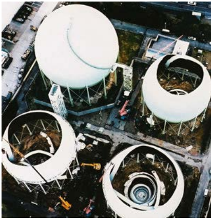
図表2: リンゴ皮むき工法 出所: 会社資料より抜粋
